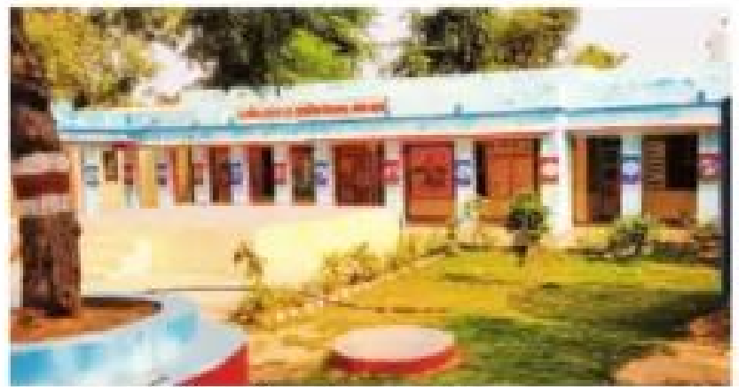
अलावर, सुध लेने के बाद निखरा विद्यालय भवन।
